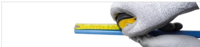
Attraverso l'utilizzo di un metro effettuare una marcatura a 20mm di distanza dall'estremità del tubo al fine di poter identificare il corretto e completo inserimento del tubo nel raccordo.
